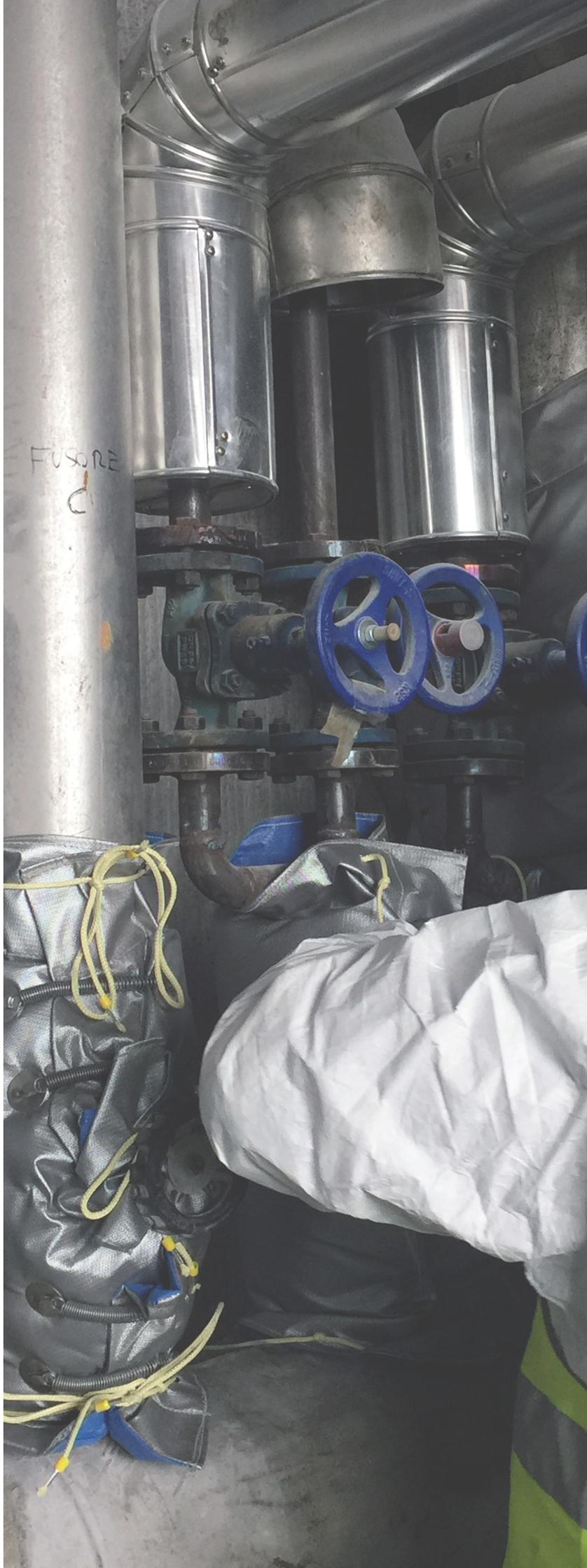
Le coperture tessili **Insul.Coib®** sono state studiate per l'isolamento termico e acustico di motori e impianti. Questi prodotti sono facilmente adattabili a diverse esigenze industriali. Grazie alle loro caratteristiche fisiche e tecniche sono in grado di proteggere i componenti contenendo le dispersioni termiche e riducendo di conseguenza i costi di gestione. La facilità nell'installazione di questi manufatti, inoltre, porta ad avere costi di applicazione ridotti.
